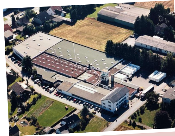
Changement de site dans la ville de Kirchlengern
